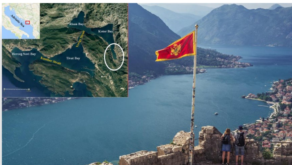
Slika 3 : Prikaz lokacije grada Kotora i pogled
